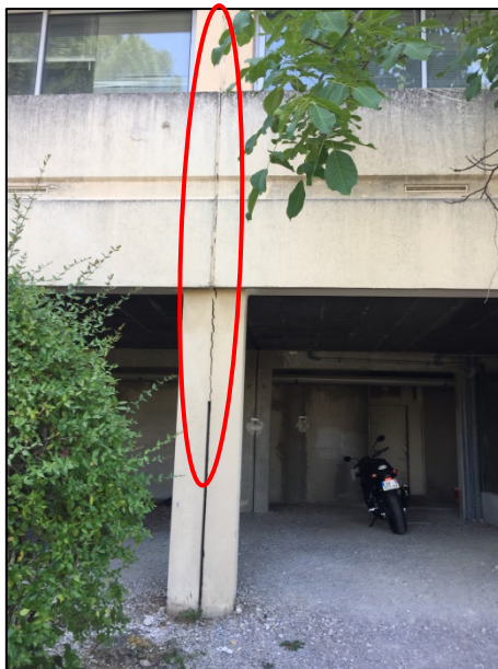
Figure 4 : Photographie de la façade Nord-Est (désordres entourés en rouge)
